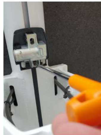
1.4 Schroef de twee Inbusbouten los.
